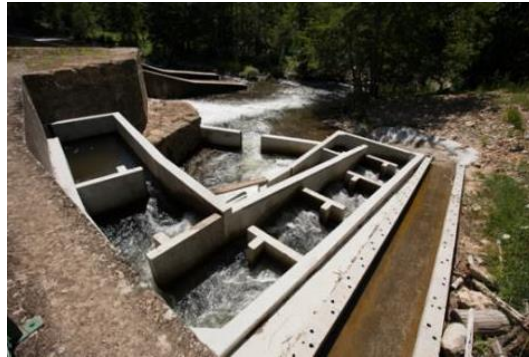
Passé à échancrures latérales "repliée" sur elle-même (© pôle écohydraulique, OFB)
