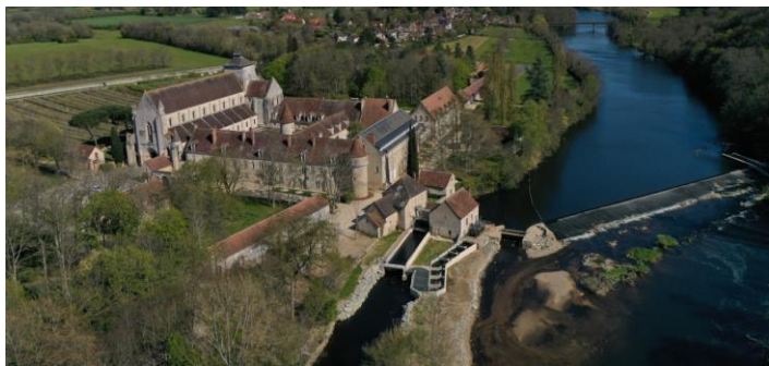
Ouvrages intégrés à un monument historique (passe à bassins successifs en rive droite et passe à macro-rugosités en rive gauche) (© G. Guillot, Seize9)
