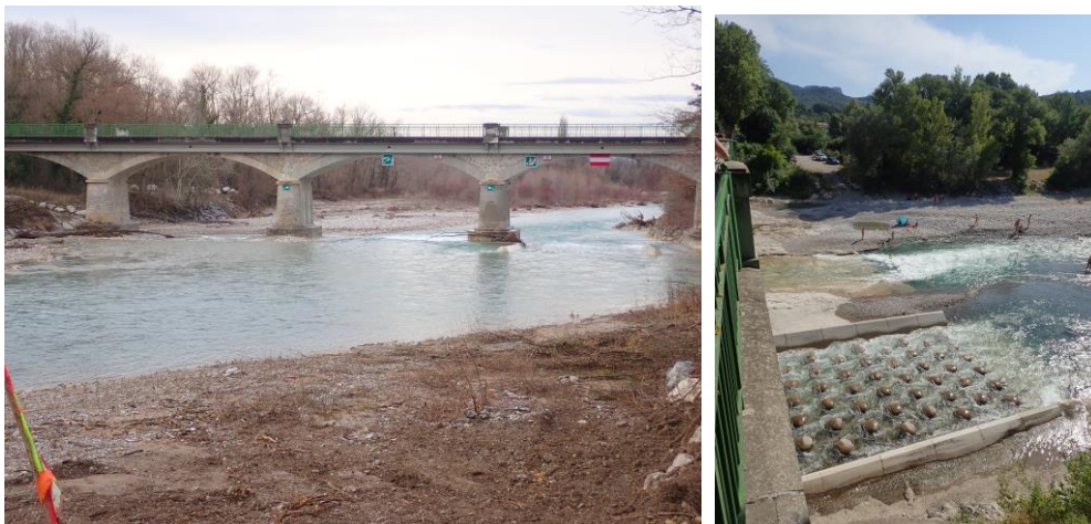
Rampe à macro-rugosités et chenal pour les embarcations (© Ph. Caillebotte, CRCK AURA)
