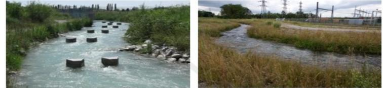
Exemples de rivières artificielles de contournement (@ pôle écohydraulique, OFB)
